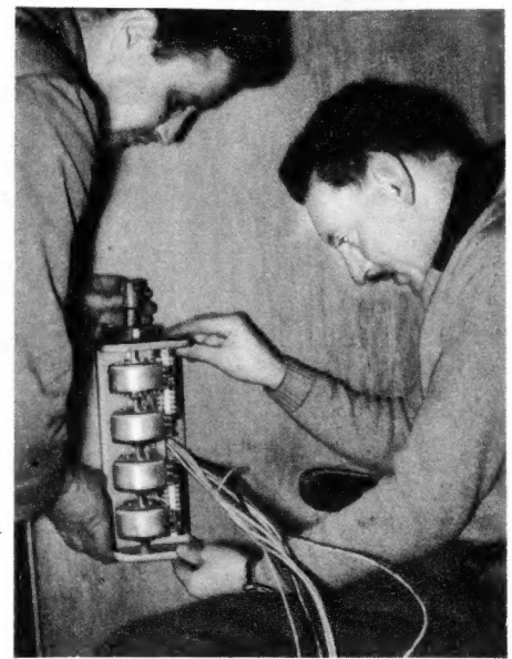
Bild 4. Montage eines Philips-Vierkanal-Saalreglers in einem Lichtspielhaus
